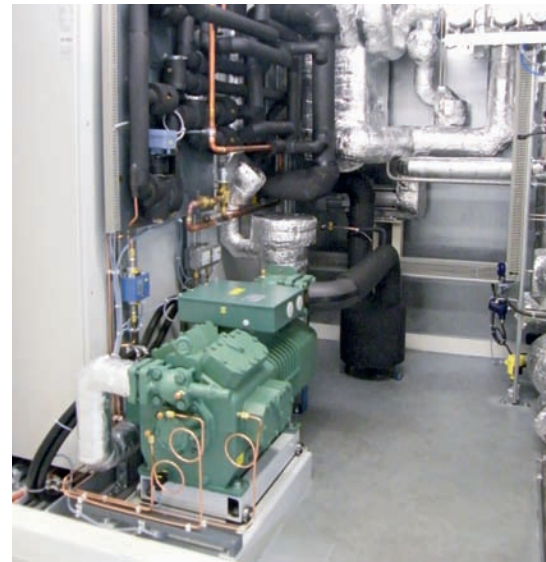
Maschinenraum eines Kryoheaters mit 54 kW Heizleistung und einer Kompressionskälteanlage mit Luftkondensator zum Kühlen (Temperaturbereich: -10 bis +400 °C)
